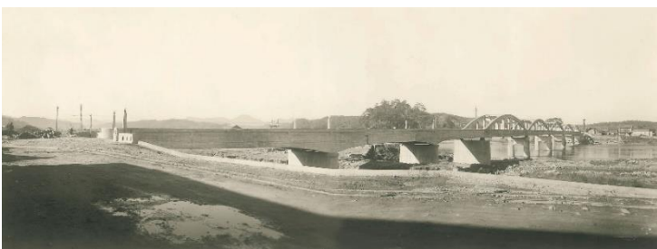
継ぎ足し・嵩上げが完了した高角橋（右岸側下流より望む）
