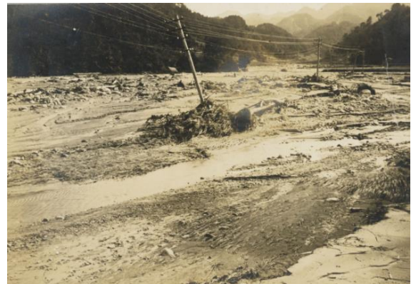
島根県邇摩郡大田村（現、大田市仁摩町大田）、潮川の氾濫による被災状況【出典：島根県「昭和 18 年 9 月水害写真」】
