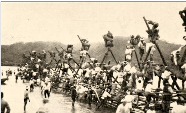
島根県簸川郡上津村（現、出雲市上島町）で実施された堤防決壊箇所の伝統止水工法「出雲結」【出典：建設省出雲工事事務所「斐伊川改修四十年史」】
