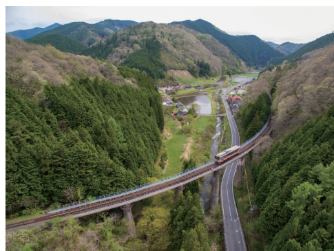
山間を走る第一小鳥原川橋梁
