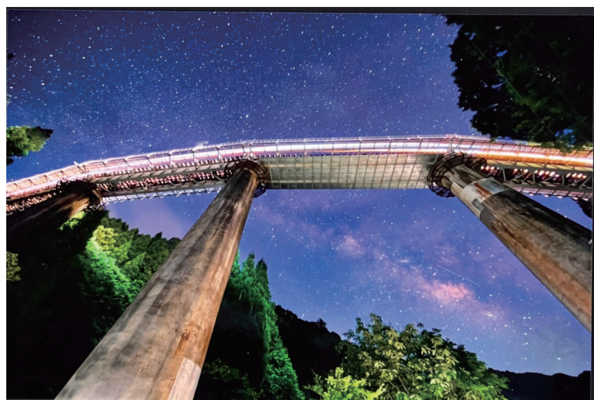
天の川に架かる第一小鳥原川橋梁 (全長 146.2 m) 鉄橋には「第 1 小鳥原川橋りょう」と書かれており、高さ 30 m、8 本の橋脚で支える。
