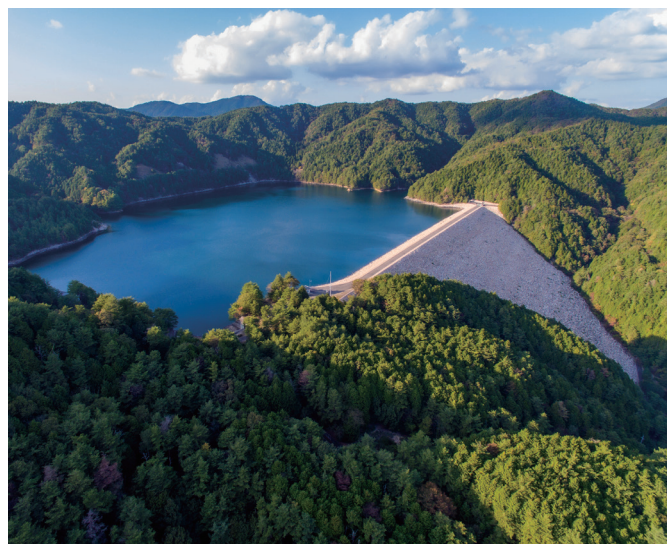
山の窪地に設置されたような上池の明神ダム 堤高88.5m、堤頂長402m、ダム体積3,268,000 m^3 、ロックフィルダム
