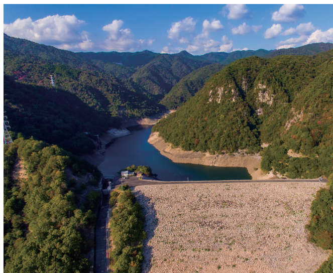
南原川を堰き止めて造られた下池の南原ダム 堤高85.5m、堤頂長305m、ダム体積2,213,000 m^3 、ロックフィルダム
