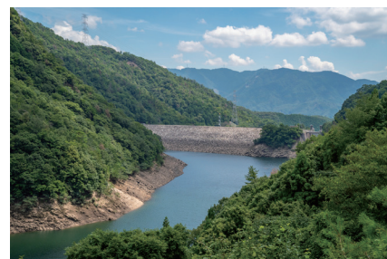
上池に揚水されているので、水位が低くなっている下池（南原貯水池）
