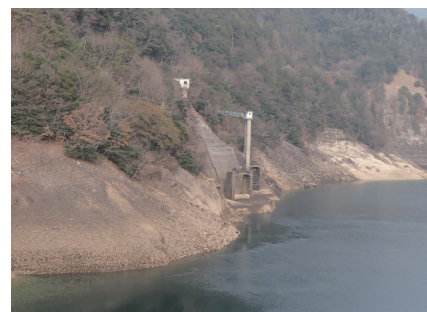
明神ダムの水は地下トンネルから発電後、南原貯水池へ放流される。2号放流口ゲート、奥は1号
