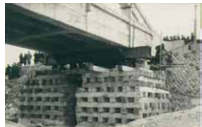
鉄筋コンクリートローゼ橋嵩上中(上下写真) 写真提供:大畑熊助氏
