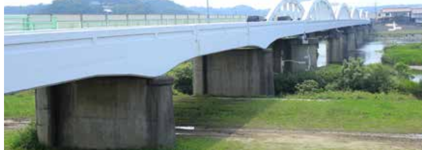
高津川に映る5連のアーチが美しい全国的にも大規模で、かつ島根県では唯一のRCローゼ桁橋。上流側の側道橋は1968年建設。
