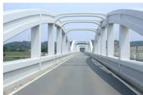
立体感を感じさせるコンクリート製のアーチリブ
