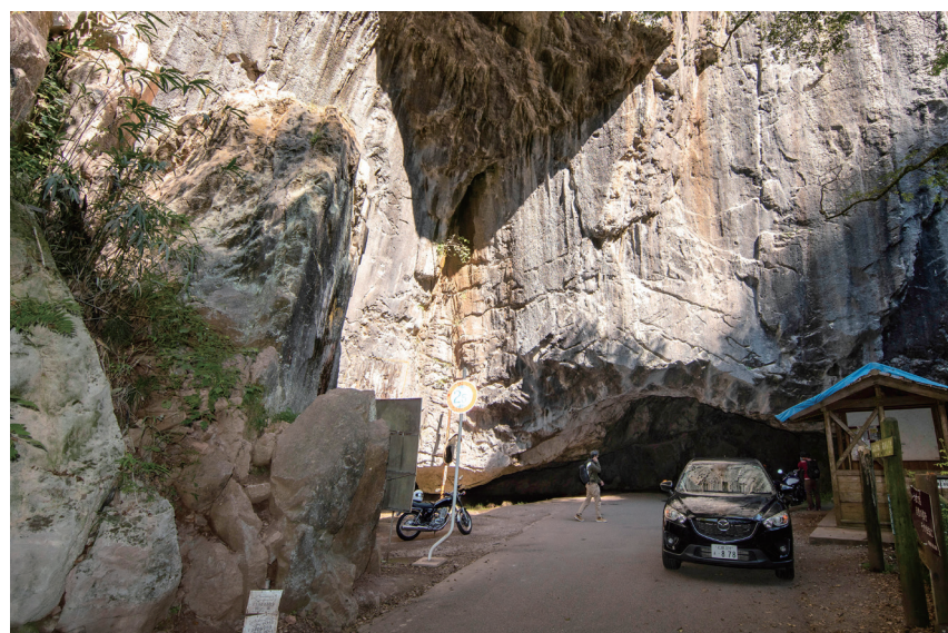
上流側の坑口が鍾乳洞の一部である羽山第二隧道
