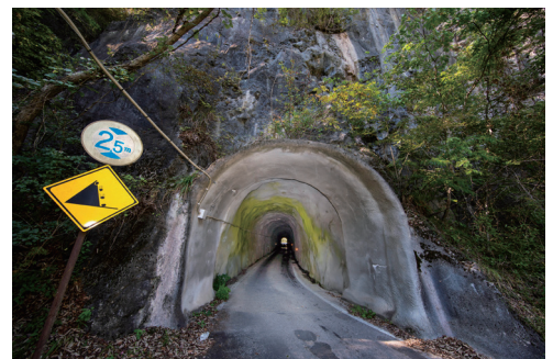
羽山第一隧道
