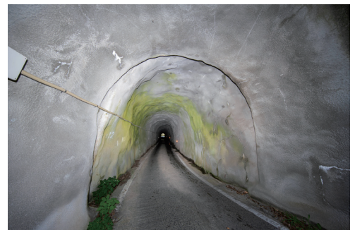
羽山第一隧道内部
