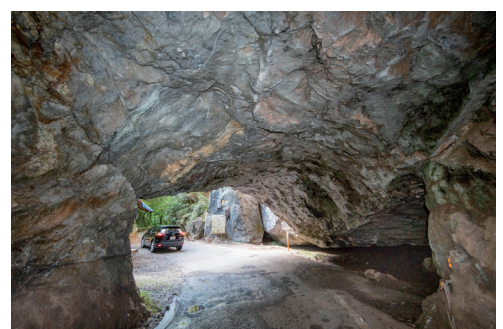
内部から見る羽山第二隧道
