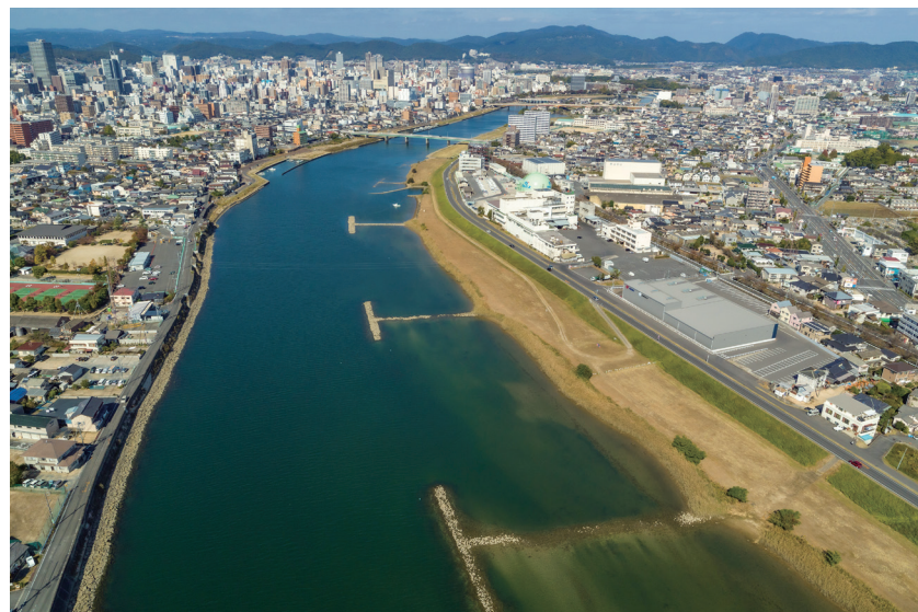
上空から見た旭川のケレップ水制（平井地区）
