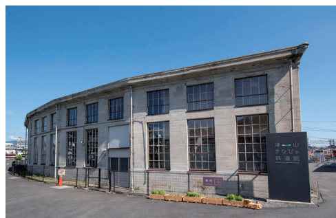
扇形機関車庫の外観
