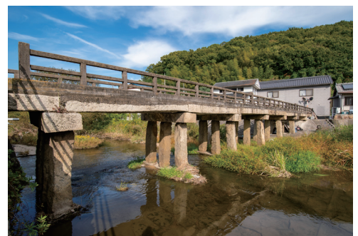
秀天橋の橋桁と橋脚
