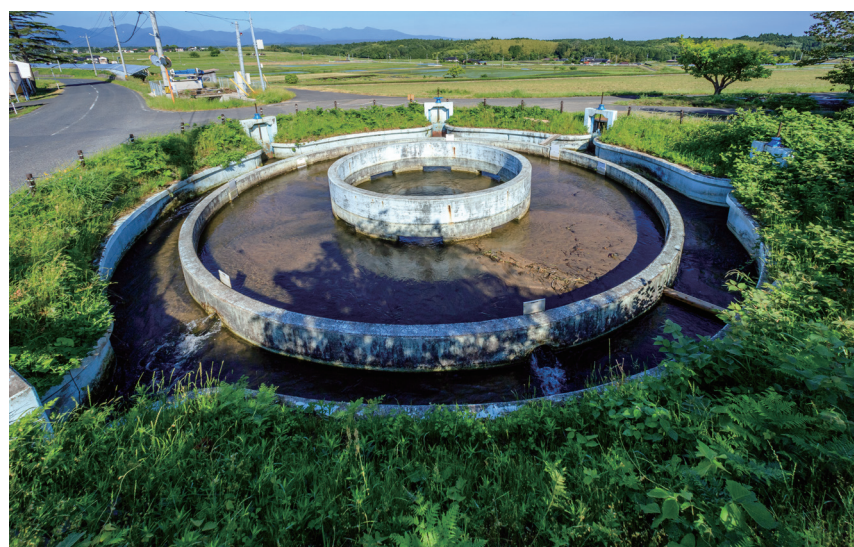
天神野円筒分水工 県内唯一の農業用分水施設で、狼谷ため池からの用水を5つの水路に分水するモノで、昭和43年(1968)に作られた。地下から吹き上げる用水を一気に5つの水路に分ける仕組みとなっている。
