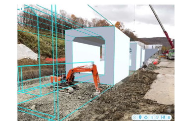
掘削作業時にARと比較
