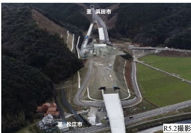
【写真②】静間・仁摩道路 仁摩・石見銀山IC付近の施工状況
