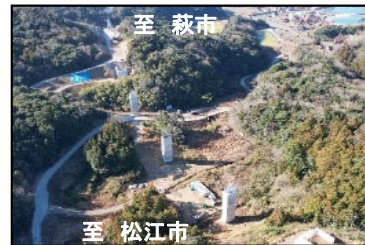
三隅・益田道路
